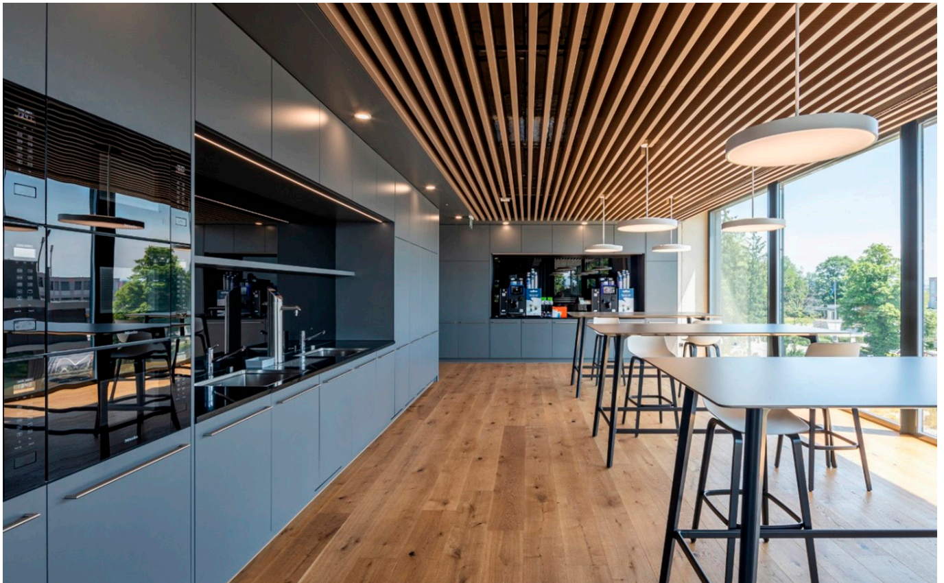
Fig. 10: Les baffles sont une autre forme d'absorbeurs au plafond. Sur l'image, on voit des baffles chauffants/rafraîchissants avec des installations supplémentaires en matériel d'absorption acoustique (non-tissé acoustique et matelas en laine minérale).
