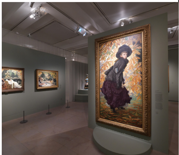
Musée d'Orsay, Paris Centrales de traitement d'air GOLD et COMPACT et diffuseurs de reprise et de soufflage COLIBRI
