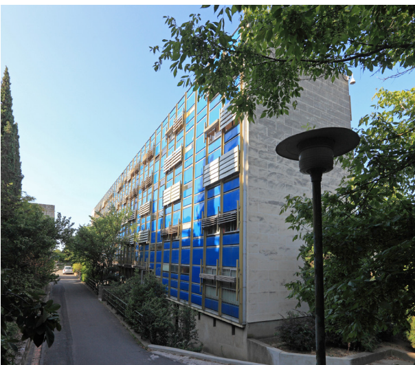
Lycée Jean-Moulin, Béziers Centrales de traitement d'air GOLD RX, diffuseurs et système climatique à la demande WISE
